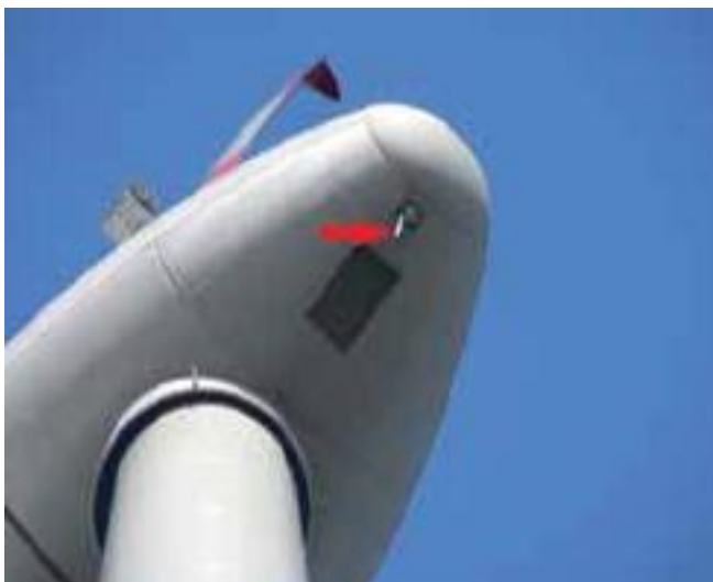
Figure 3.16 : Microphone d'enregistrement à distance placé sur le dessous de la nacelle. Il est relié à un détecteur automatique installé à l'intérieur de la nacelle. Photo : L. Bach ©
