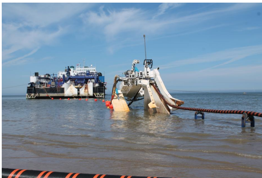
Figure 97 : Opération d'ensouillage d'un câble par une charrue sur l'estran (source : RTE).
