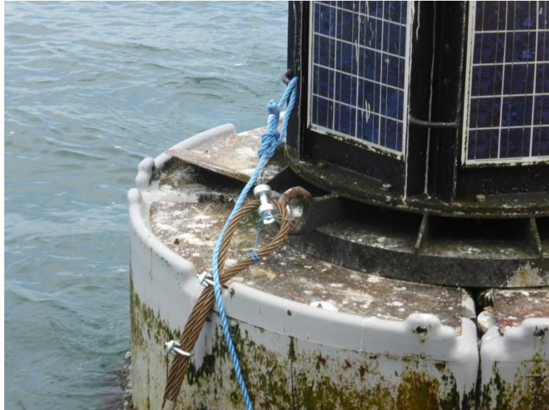
Figure 6a. Fixation du câble acier sur la balise.
