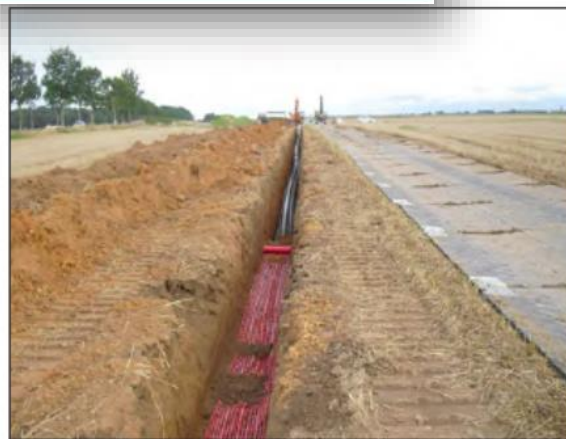
Pose de fourreaux PEHD en pleine terre
